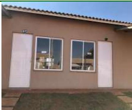
A pintura (externa) das paredes foram executadas com fundo preparador, uma demão de textura acrílica nas cores palha e camurça/pão de ló, e uma demão de tinta látex nas cores palha e camurça/pão de ló, textura marca Dois Irmãos Comércio Varejista de Tintas e a tinta látex na marca Qualycril.
