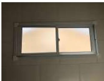
**Banheiro:** 1 Janela em alumínio 120 x 50 cm, 2 folhas de correr, sendo 2 folhas móveis com vidro mini boreal 3 mm, marca METALURGICA MACHADO.
