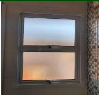
**Cozinha:** 1 Janelas Maxim AR basculante em alumínio, 2 folhas, sendo 2 folhas móveis de 50 x 150 cm, com vidro mini boreal 3 mm, marca METALURGICA MACHADO.
